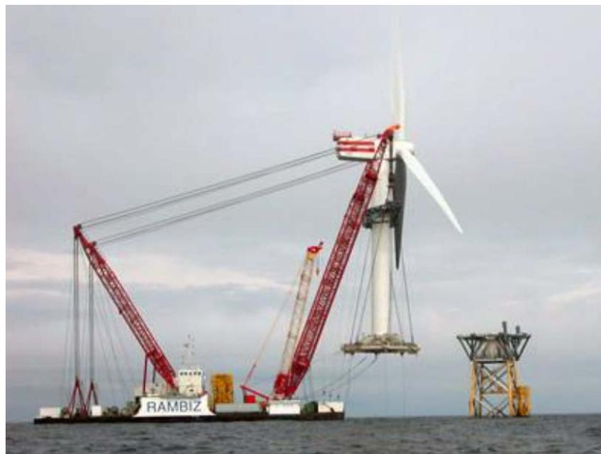
**Ilustración 18:** Transporte de un aerogenerador premontado a su ubicación.
