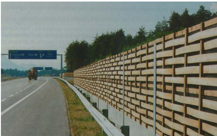
Figura 4.1. Pantalla en madera absorbente. Austria.
