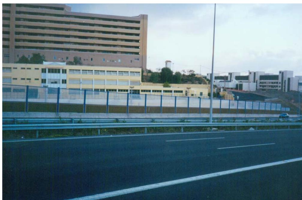
Figuras 4.3. (a) y (b). Pantalla artificial con base de hormigón absorbente y elementos transparentes en la parte superior. Las Palmas de G.C. (España).
