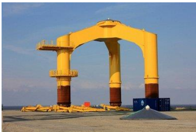
Figura M-4: Estructura de soporte tripilote [3].
