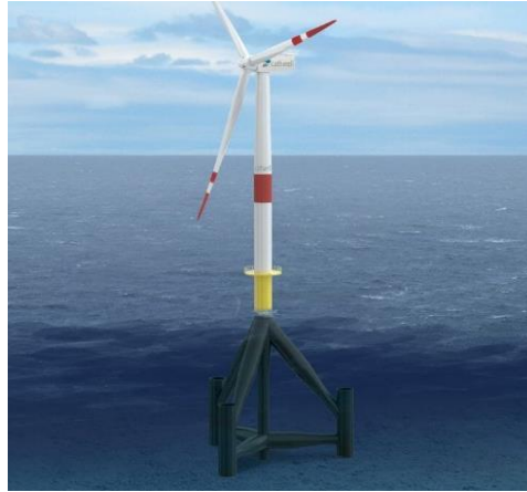
Figura 6. Aerogenerador sobre cimentación trípode. Fuente: [11].
