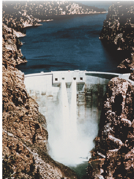
Figura 4. Fotografías de la presa de Morrow Point
